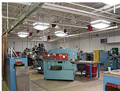
Fig. 5.15 – Exemplos de aplicação dos “Skylite” ( www.dayliteco.com ).
