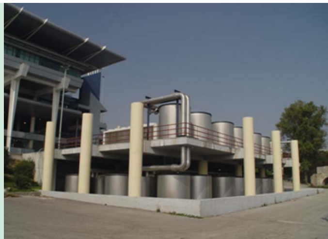
Fig. 5.14 – Sistema de bancos de gelo.
